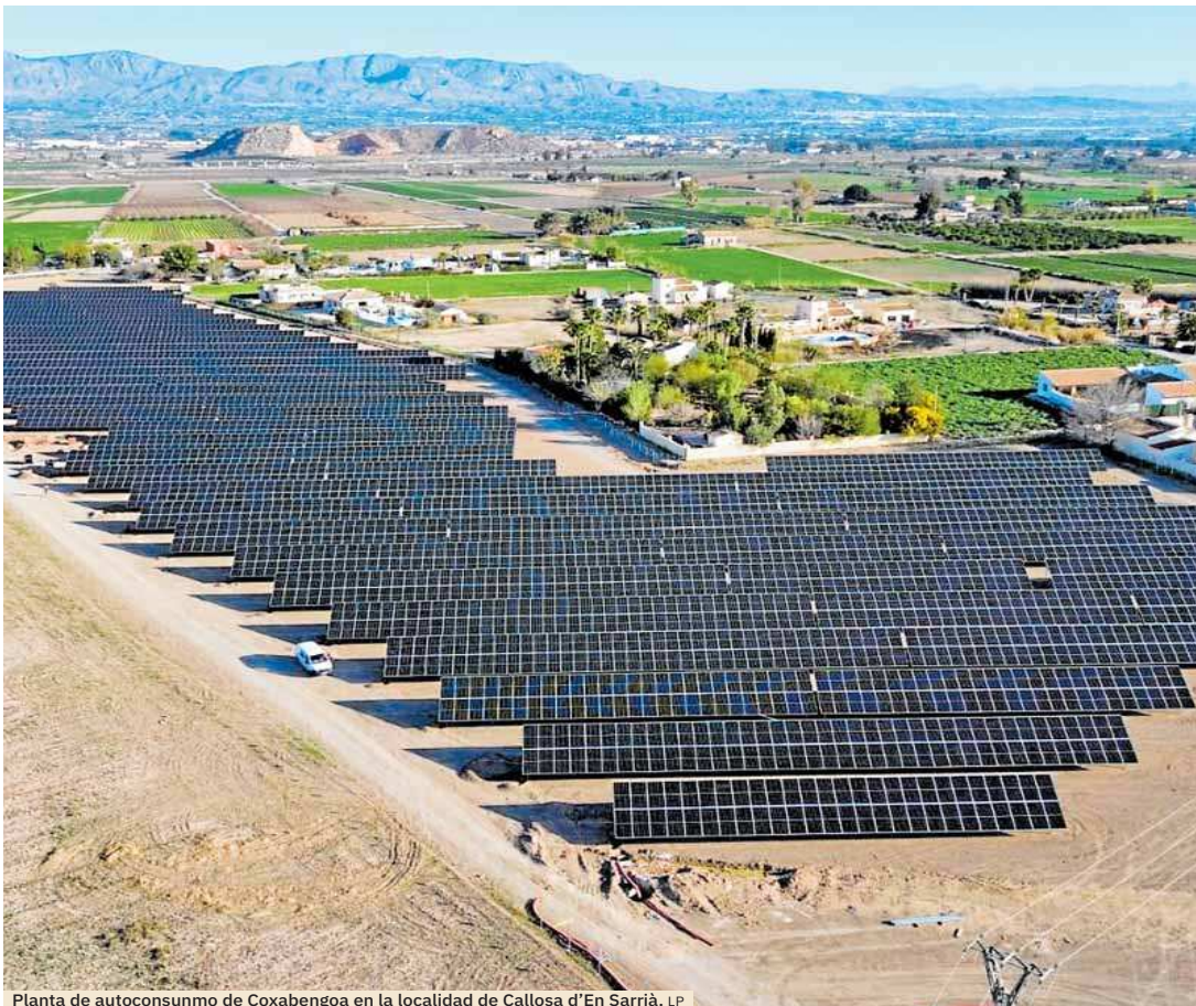
Planta de autoconsumo de Coxabengoa en la localidad de Callosa d'En Sarrià. LP
