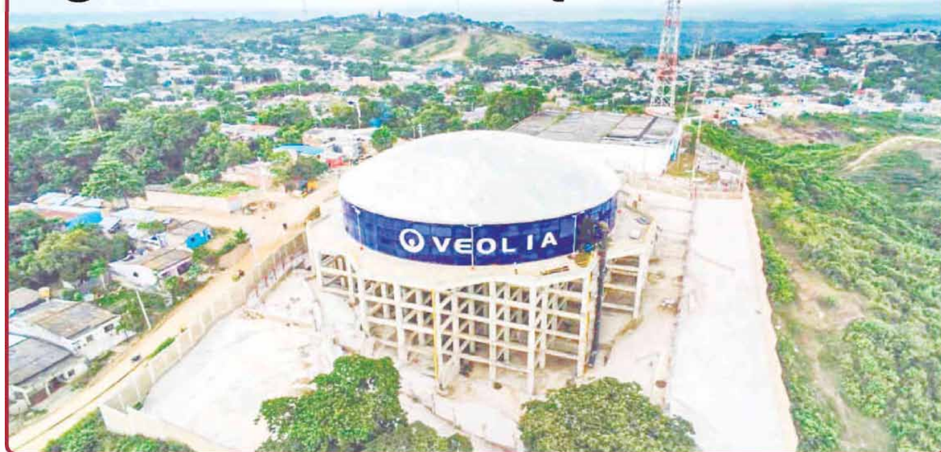
Veolia busca aumentar el caudal de bombeo del tanque La Pollita.
